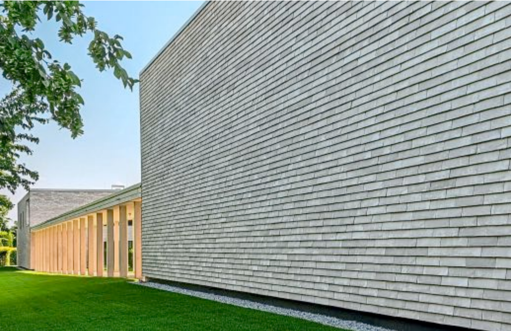
Ein Säulengang verbindet Depot (vorne) und Ausstellungsgebäude.
